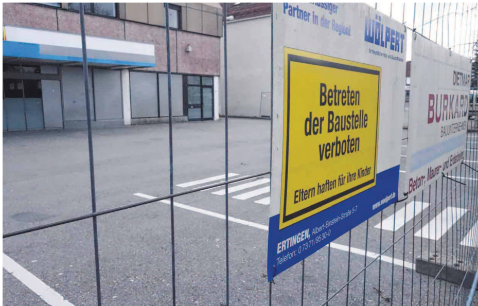
Noch wird hier nicht gebaut. Aber Stadtverwaltung und Gemeinderat möchten, dass es an dieser Stelle an der Paradiesstraße wieder einen Lebensmittelmarkt gibt. Dazu bringen sie eine Änderung des Bebauungsplans auf den Weg.
