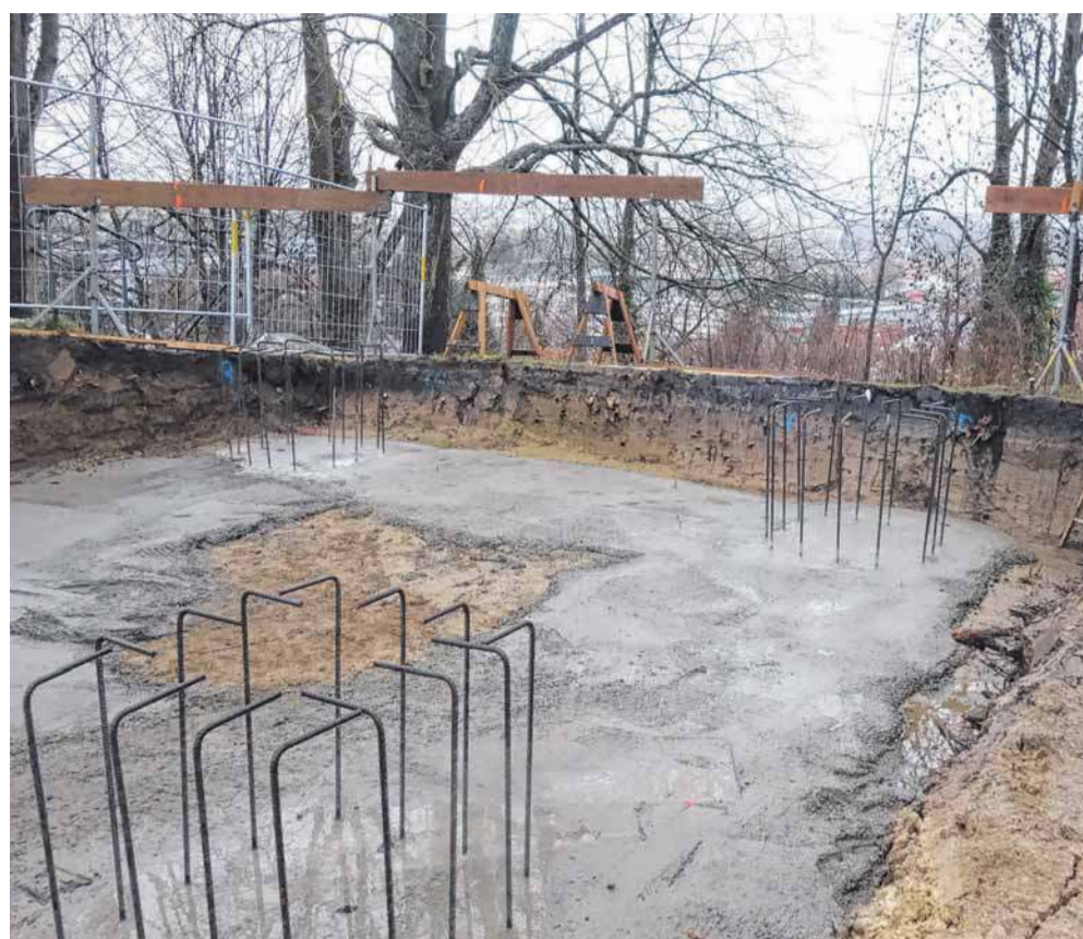
Sichtbare Veränderung: Das Foto links entstand in der vergangenen Woche. Über den vier Bohrungen ragen Stahlteile aus der Erde. Das rechte Foto von Montag zeigt bereits den Fortschritt beim Aufbau der Beton-Stahl-Konstruktion
